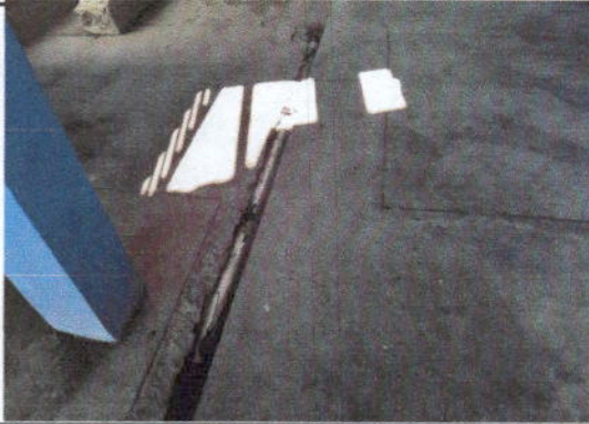
Foto 1: Piso de aulas que será sustituido.
