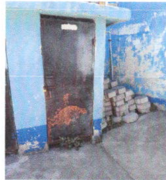
Foto 4: Puertas de baños que se le darán mantenimiento.
