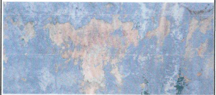
Foto 6: Muro interior a pintar
