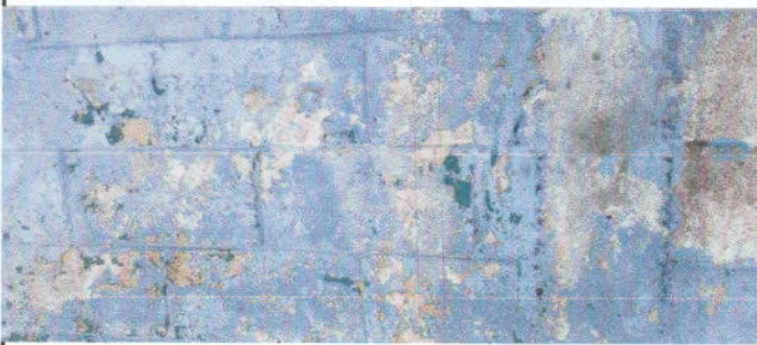
Foto 3: Muro exterior a pintar.
